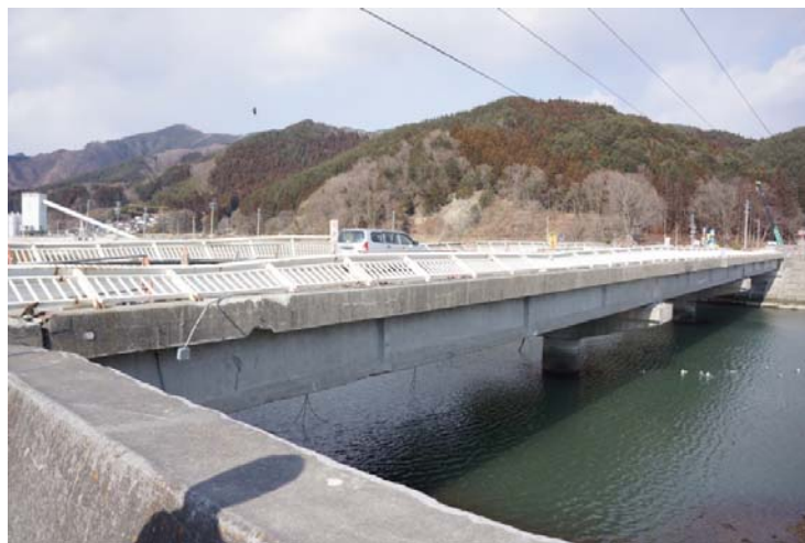
大槌大橋 現況
