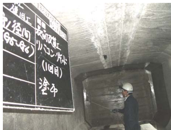
②リバコン・リキッド塗布工
